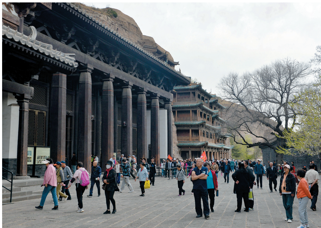
“五一”假期即将来临,我市旅游也将迎来客流高峰。为备战“五一”假期,云冈石窟景区早动手、早准备,做好各项服务保障工作,确保游客度过一个欢乐、祥和的假期。图为近日,云冈石窟景区已迎来四面八方的游客。 本报记者 戎禹仁 摄
