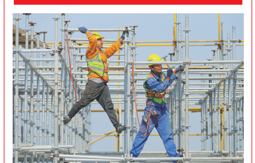
5月1日,在山东省青岛市李沧区楼山创忆空间项目(二期)施工现场,工人进行内架搭建设工作。当日是“五一”国际劳动节,各行各业的劳动者坚守岗位,在一线忙碌。 新华社发 张鹰摄
