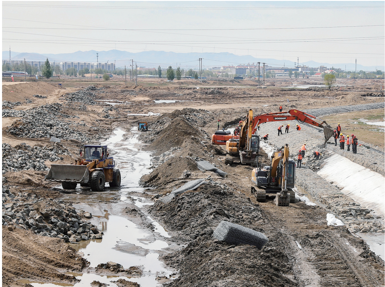
连日来,天镇县南洋河生态治理二期工程加紧推进施工进度。
