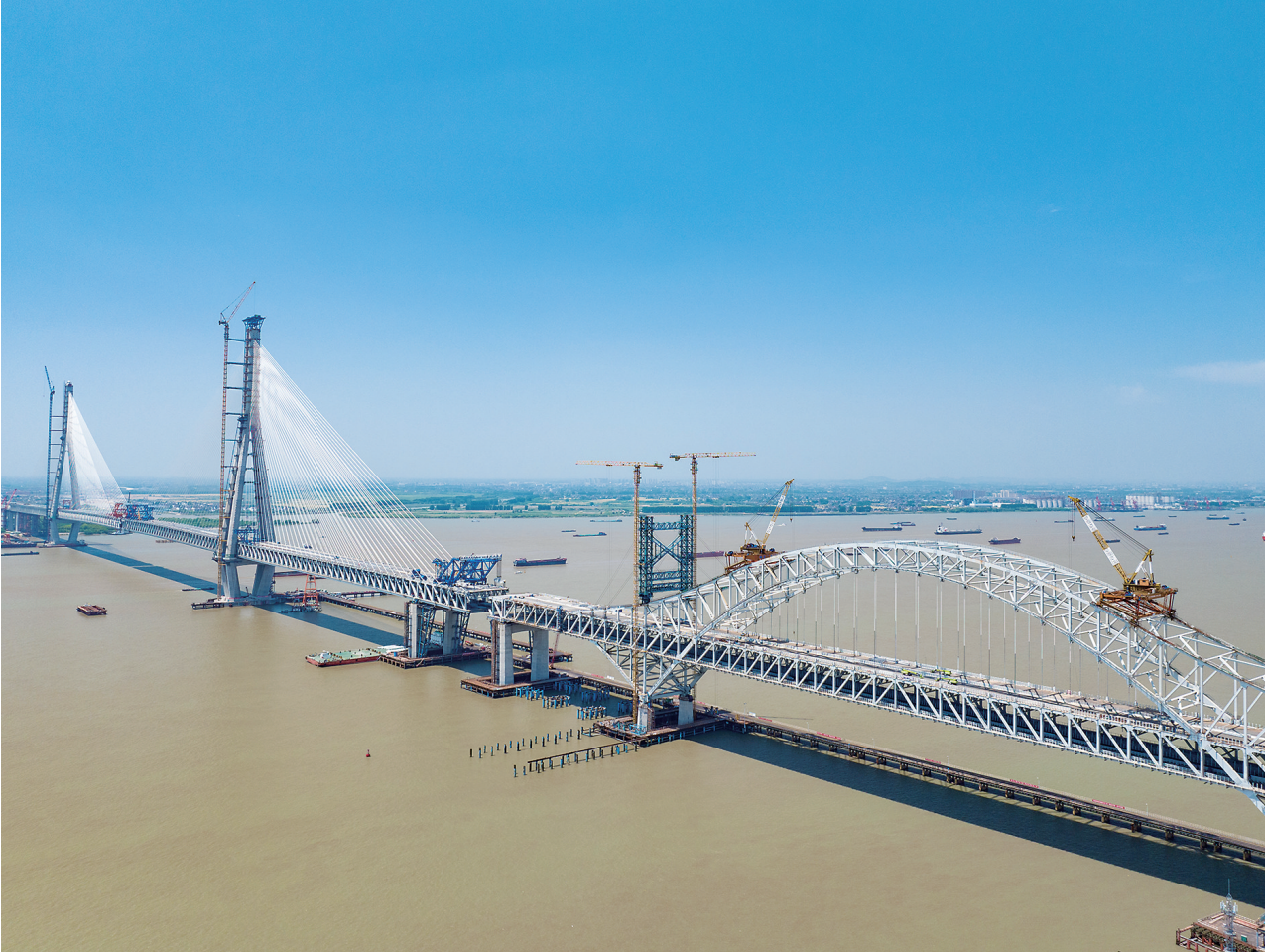
建设中的常泰长江大桥（5月17日摄，无人机照片）。常泰长江大桥连接江苏泰州和常州两市，全长10.03公里，是一座集高速公路、城际铁路和普通公路为一体的过江通道。新华社发（周社根摄）
