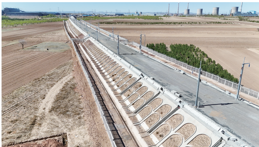
图为集大原高铁混凝土拱形骨架护坡。
