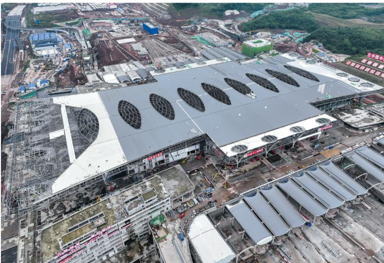
这是5月28日拍摄的重庆东站站房施工作业现场（无人机照片）。当日，西部地区最大高铁枢纽站——重庆东站钢结构屋顶正式完工，标志着重庆东站站房全面进入装饰装修施工阶段。重庆东站站房及配套综合交通枢纽工程建成后，将引入渝湘高铁、渝万高铁、渝昆高铁等多条线路，成为以高铁为核心，集轨道交通、公交、商业与办公为一体的综合性交通枢纽。新华社记者 王全超摄
