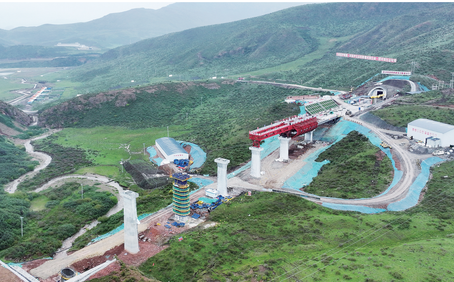
这是6月3日拍摄的建设中的西成铁路甘肃段白龙江大桥（无人机照片）。
