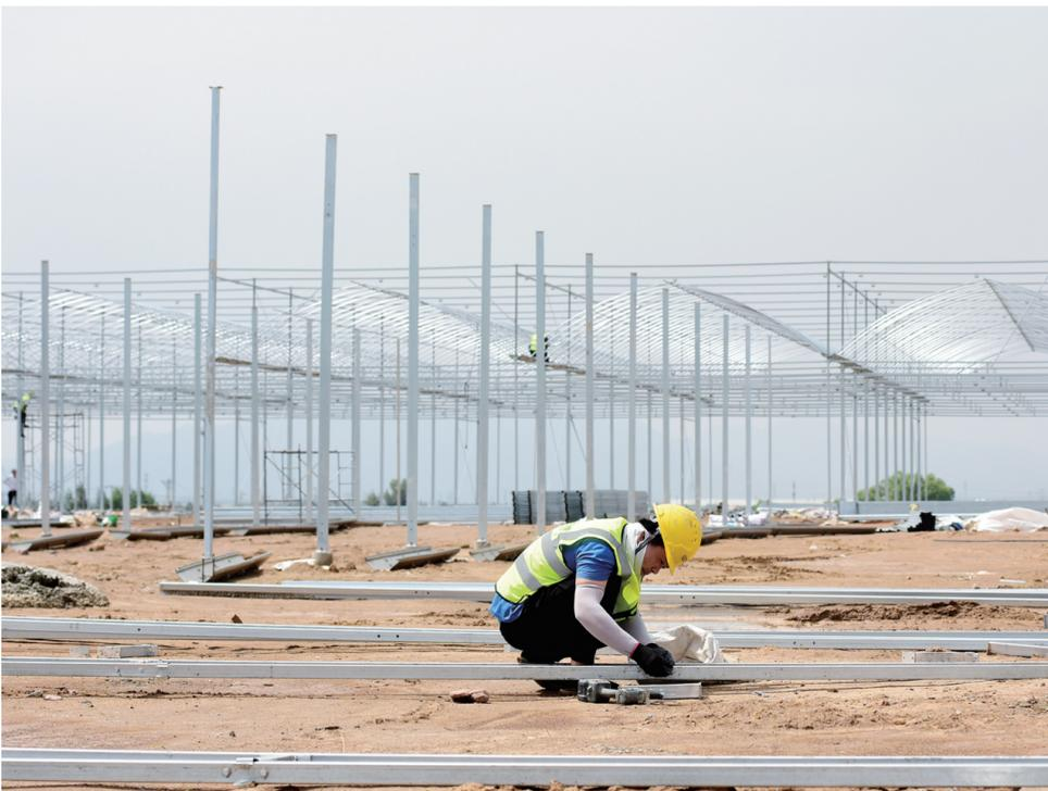
作为省重点项目,云州区慧农现代农业科技产业园项目投资3.64亿元的一期工程正在加紧施工,目前已完成工程总量的75%。图为施工人员在架设育苗联动温室主体结构。本报记者 于宏摄
