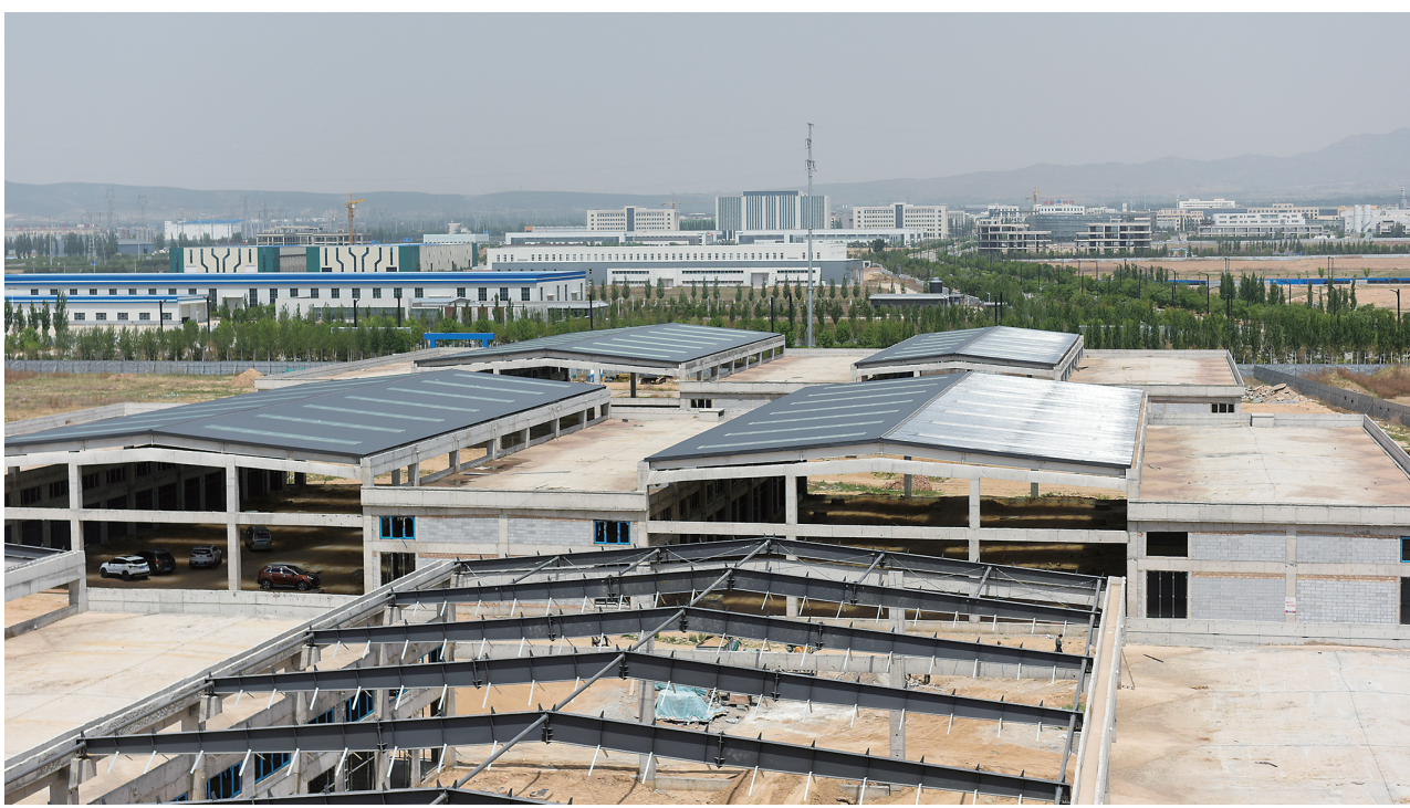
图为正在建设中的华兴大同农批城。
