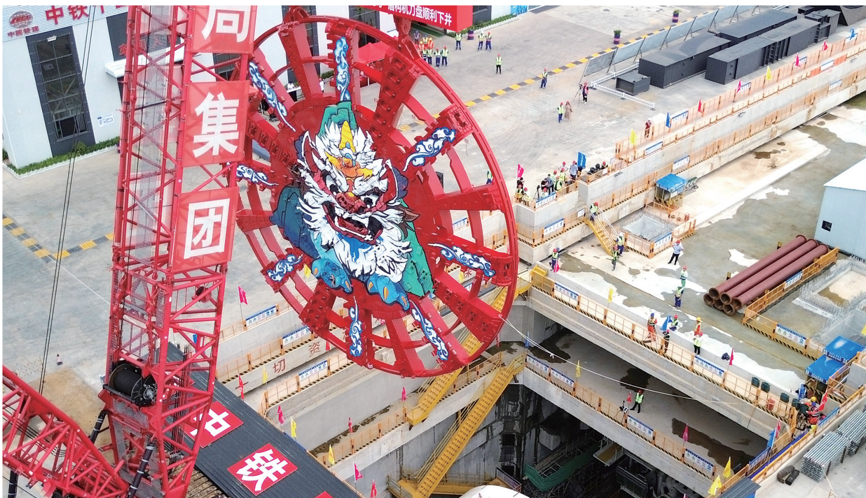
7月24日,“山河号”盾构机刀盘被履带式起重机从地面吊运至济南市黄岗路穿黄隧道盾构始发井(无人机照片)。当日,由中铁十四局集团承建的济南市黄岗路穿黄隧道“山河号”盾构机刀盘顺利吊装下井,为黄岗路穿黄隧道盾构机始发穿黄奠定坚实基础。黄岗路穿黄隧道是济南市跨黄河通道总体布局中的重要一环,工程建成后助力济南主城区与新旧动能转换起步区互联互通,促进济南跨黄河发展。
