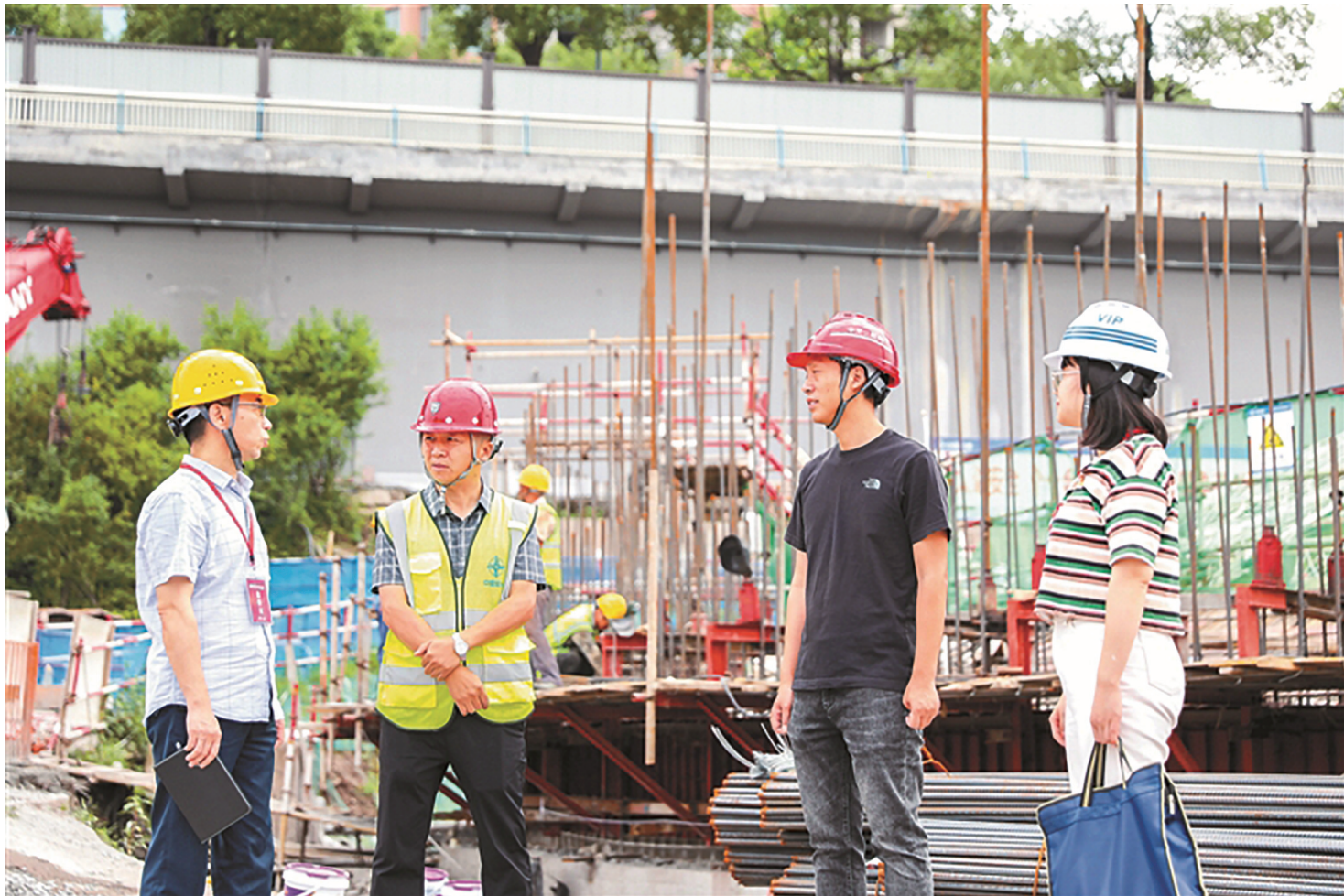
重庆市南岸区纪委监委严查党员干部违规干预和插手市场经济活动行为及其背后的腐败和作风问题。图为该区纪检监察干部走访辖区某项目建设现场了解相关情况。陈佳佳摄
