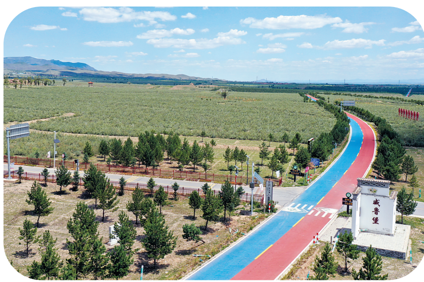
图为长城一号旅游公路串联起管家堡乡境内摩天岭、八台子、宁鲁堡、月华池等多处旅游景点。
