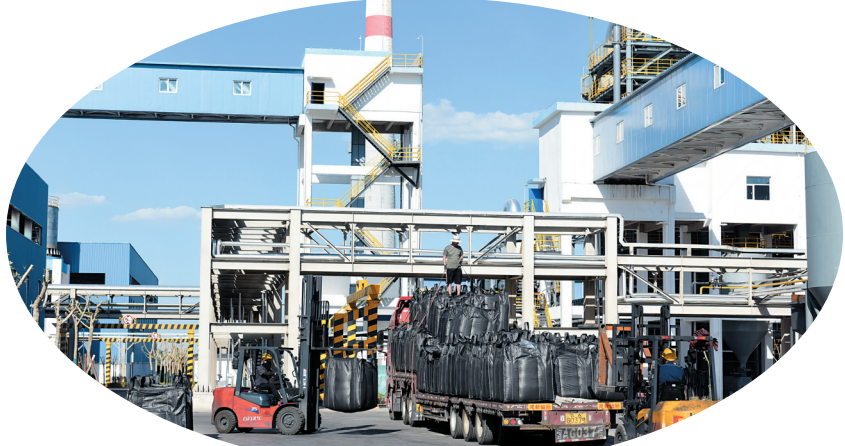
厂房之间的路面干净平整。
