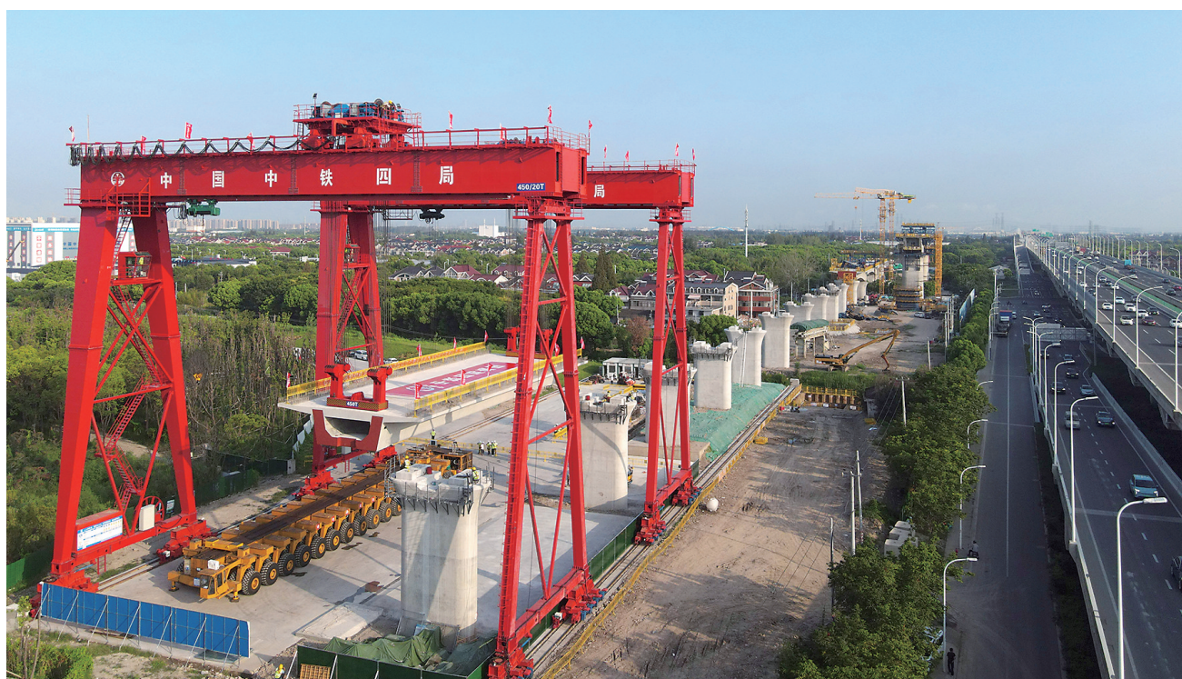
空中俯瞰沪渝蓉高铁上海段首箱梁架梁施工现场(8月26日摄,无人机照片)。当日,由中铁四局承建的沪渝蓉高铁上海段首箱梁架梁完成,标志着该段正式进入桥梁架梁阶段。上海段是沪渝蓉高铁东段线路的重要组成部分,沪渝蓉高铁东段线路项目建成后,对于优化沿长江地区铁路网布局、服务长江经济带协同发展,推动长三角高质量一体化发展等具有重要意义。新华社记者 方喆摄
