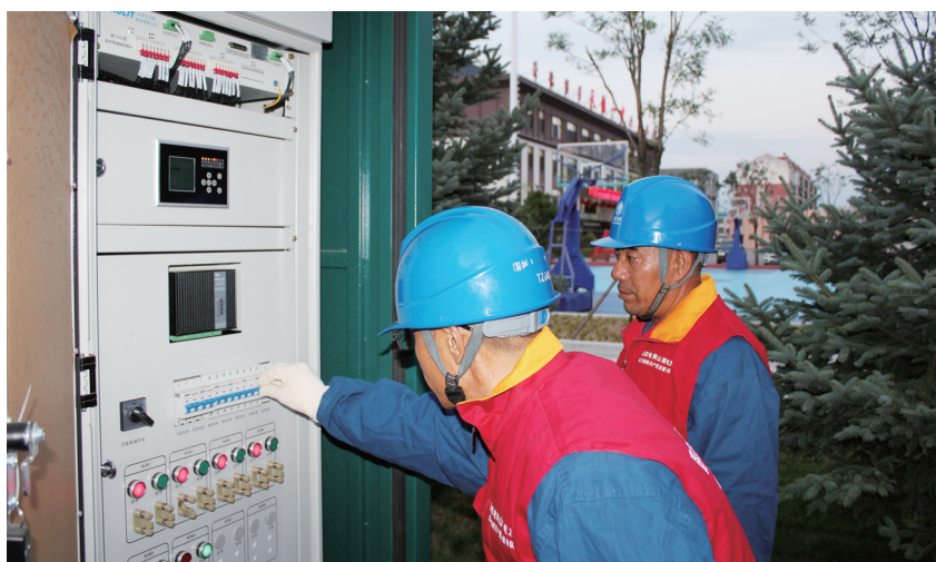
连日来,国家电网山西电力(大同天镇)太行黎明共产党员服务队开展校园用电安全大检查,截至目前,共排查中小学12所,更换漏电保护器6个,处理各类用电隐患4处,发放安全用电宣传资料250份,为新学期校园用电撑起“安全伞”。张华摄
