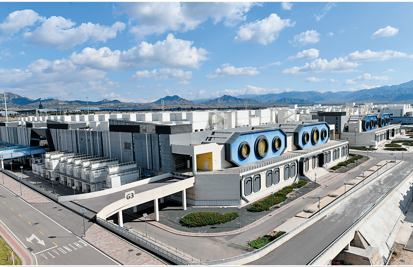
位于灵丘县的泰康数据环总部·太行山能源信息技术产业基地。
