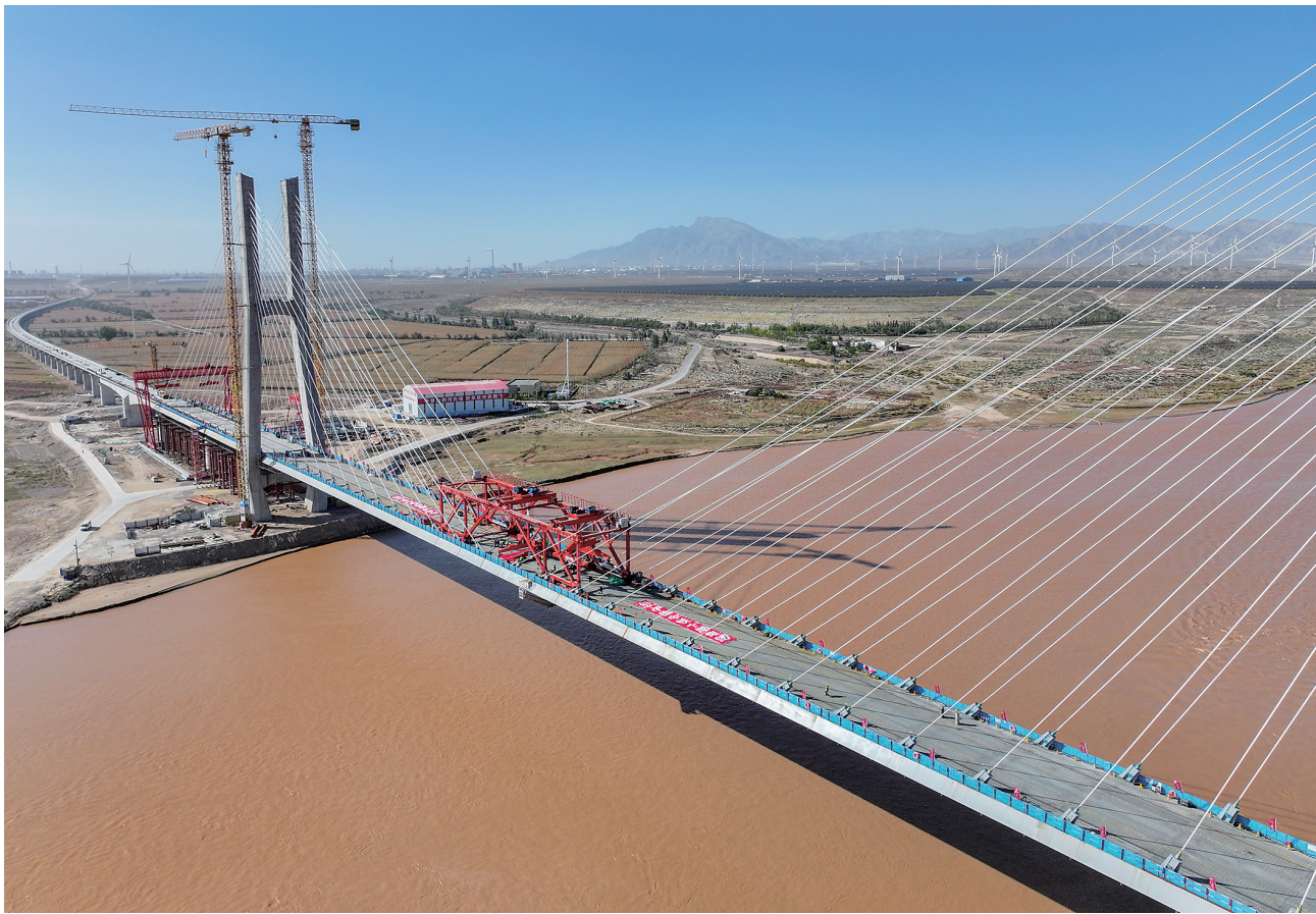
10月9日，包银高铁乌海黄河特大桥合龙贯通（无人机照片）。当日，包银高铁乌海黄河特大桥顺利合龙贯通，为线路早日建成通车迈出坚实一步。包银高铁是我国“八纵八横”高速铁路网京兰通道的重要组成部分，设计时速250公里，是西北地区连接东北、华北地区的交通大动脉和经济大通道。新华社记者 连振摄
