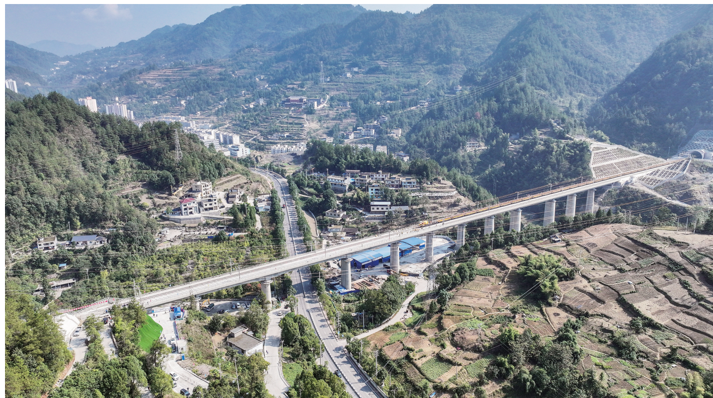
这是10月9日拍摄的渝厦高铁重庆东至黔江段铺轨施工现场(无人机照片)。当日，在重庆市黔江区渝厦高铁马家桥施工现场，第一组500米长钢轨稳稳落下，标志着渝厦高铁重庆东至黔江段全面进入铺轨阶段。渝厦高铁重庆段从重庆主城区到黔江区，全长269.5公里，是国家中长期铁路网规划的“八纵八横”高铁网中渝厦通道的重要组成部分。 新华社记者 唐奕摄
