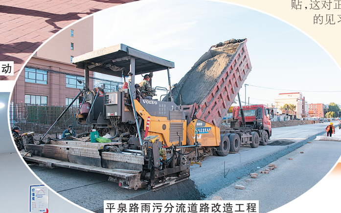
平泉路雨污分流道路改造工程
