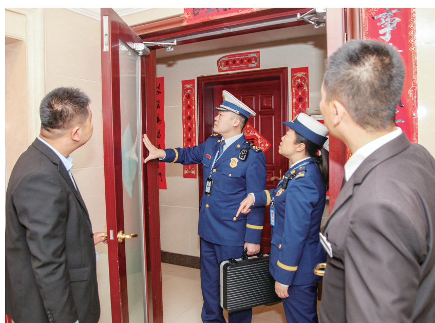
连日来,平城区水泊寺街道联合平城区消防救援大队对辖区进行消防安全检查,旨在进一步排除安全隐患,增强社区居民的安全防范意识,也为即将到来的冬季筑牢一道坚实的“防火墙”。图为10月16日,消防监督检查人员检查恒和社区防火门。
