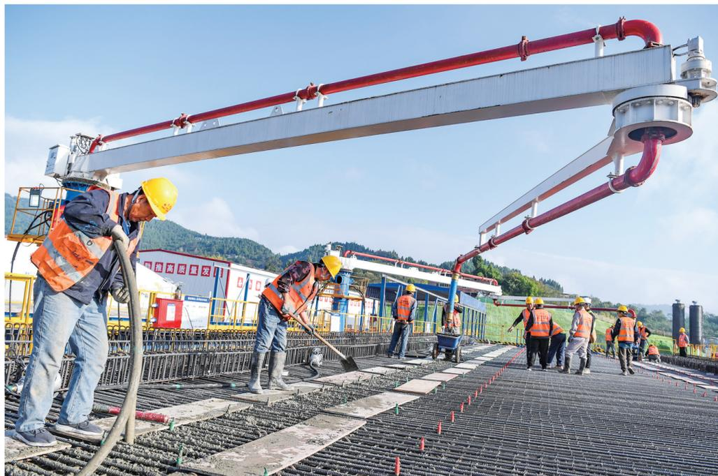
10月18日，在中铁十一局渝万高铁万州响水镇制梁场，工人正在进行预制箱梁浇筑作业。
