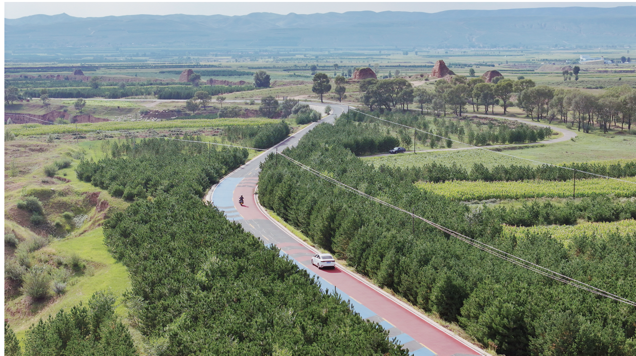
图为大同长城一号旅游公路新荣区云墩段。
