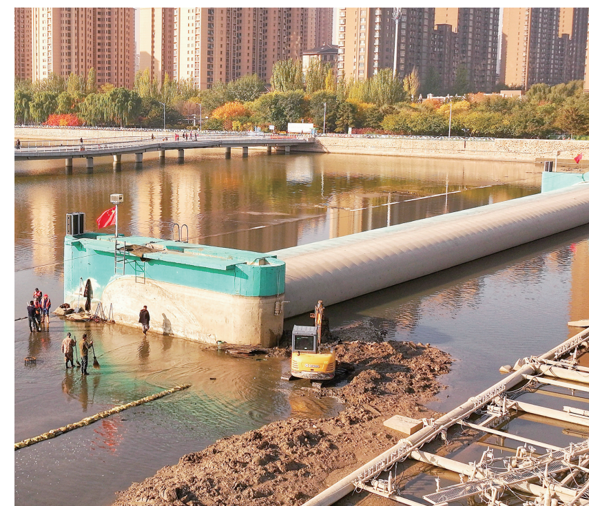
位于迎宾桥和南环桥之间的橡胶拦水坝已超过安全使用年限，为防止发生隐患，昨日，施工方开始对该拦水坝进行更新安装，新坝安装完成后，该水域将重现水天一色的景观。图为施工现场。
