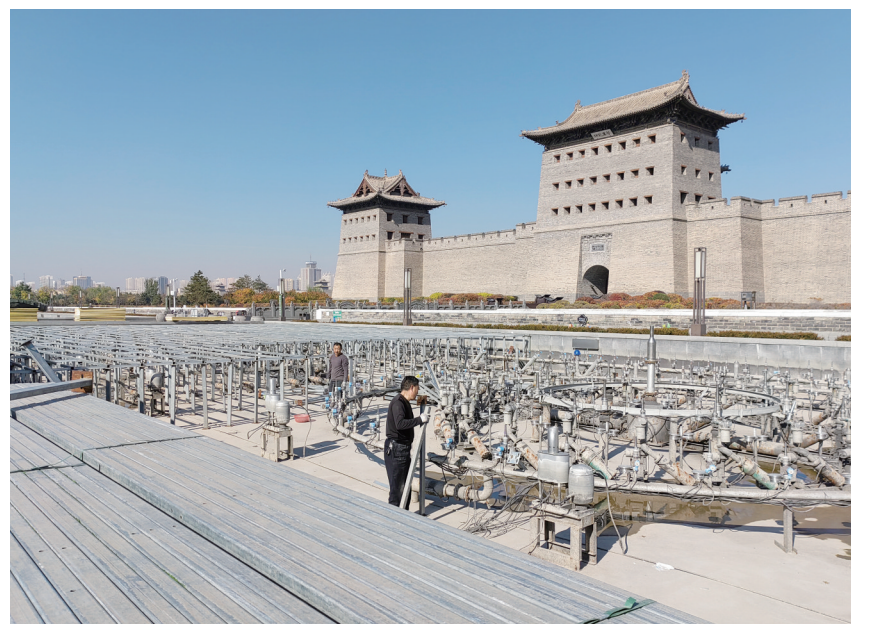
为保障喷泉设施安全越冬，连日来，山西永泰物业公司工作人员加紧为音乐喷泉搭建维护设施。10月28日，记者在永泰门广场音乐喷泉池前看到，施工人员已备好相关物料，正在喷泉池内搭建钢架龙骨。 本报记者 戎禹仁摄
