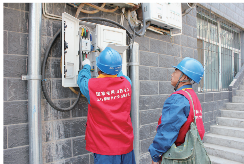
为保障广大用户安全用电、温暖过冬，11月4日，国网天镇县供电公司工作人员深入五里镇东南街居民家中入户走访，开展服务，对相关供电设施进行现场排查，梳理薄弱环节，整改处理缺陷。同时，大力宣传冬季安全用电及采暖知识，发放便民服务卡，及时了解和解决客户诉求，提升客户冬季取暖用电获得感。 张华摄
