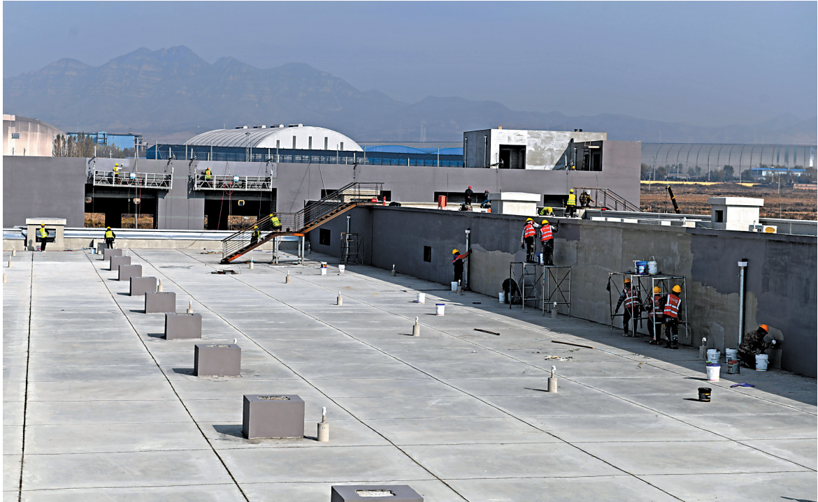
图为零碳数基·桃花源大同灵丘超级能源综合体基地项目已封顶的算力中心大楼，工人们正在进行防水作业。本报记者 于宏摄
