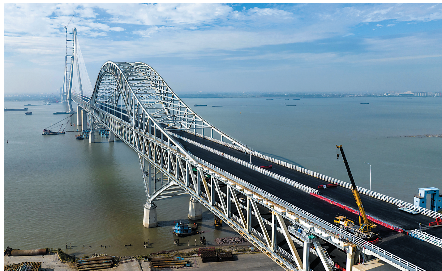
常泰长江大桥钢桥面主体铺装完成 这是十一月十日拍摄的正在建设中的常泰长江大桥（无人机照片）。十一月九日，经过近三个月的紧张施工，常泰长江大桥上、下层钢桥面主体铺装全部完成。这是这座世界最大跨度斜拉桥全线贯通后，工程建设取得的又一重大进展。常泰长江大桥连接江苏省常州市、泰州市两市，是长江上首座集高速公路、城际铁路、普通公路三种方式于一体的过江通道。 新华社发（汤德宏摄）
