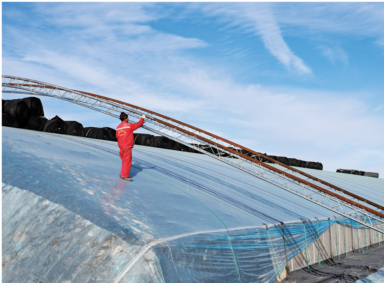
11月11日,阳高县圣阳现代高科技农业科技产业园工人为日光温室大棚建设预制件涂刷防锈漆。圣阳现代高科技农业科技产业园是阳高县与山东省寿光市合作打造的晋北高寒冷凉地区现代设施农业标杆项目,项目一期建设日光温室大棚50座、玻璃温室2栋及相关配套设施。目前,已完成投资1.6亿元,预计12月底前投入运营。项目建成后,可进一步推动阳高县高端农业、智慧农业发展,带动全县果蔬产业走上规模化、品牌化发展之路,就近吸纳劳动力就业,促进农民增收。
