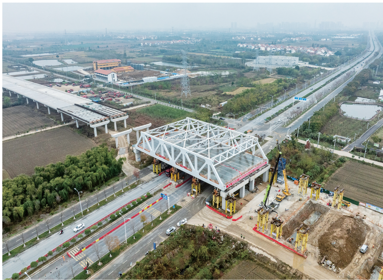
11月19日拍摄的施工现场（无人机照片）。
