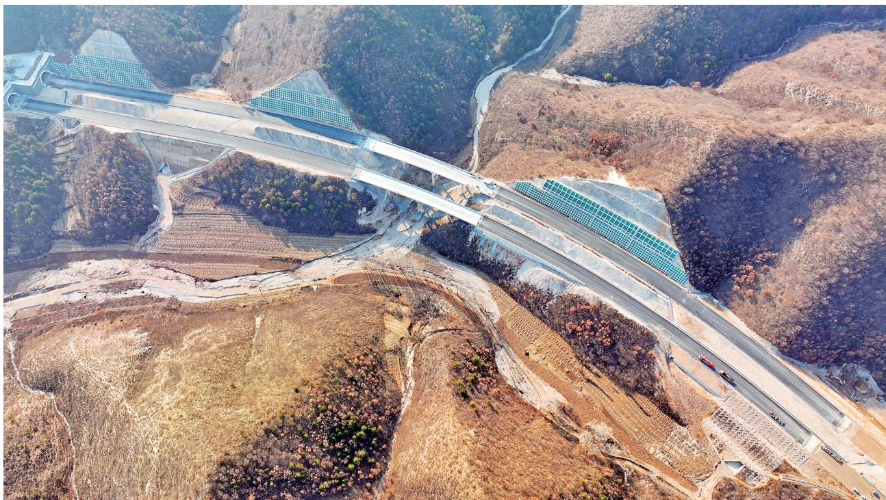
凌绥高速公路施工取得新进展
