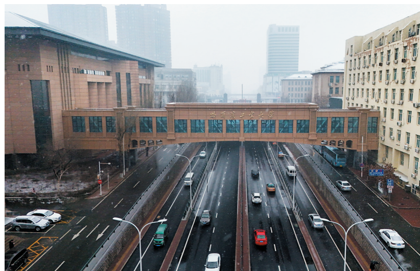
11月26日，我国最北省会城市哈尔滨迎来降雪降温天气。在哈尔滨工业大学，校园内温暖如春，师生们身着薄衣在暖廊间穿行，5分钟内可实现教室、图书馆、食堂、公寓以及体育馆等地点之间的“直达”。从2022年开始，哈工大分期实施校园暖廊建设，打造温暖、便捷的学习生活环境。当前，暖廊一至四期总通行长度达4190米，有效缓解极端天气对校园生活的影响。同时，暖廊结合影廊同步建设了展示型、学习型等多种功能的校园文化长廊和一站式学生社区，实现了效用最大化。
