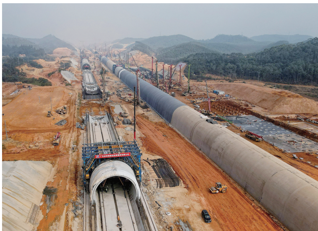
12月10日拍摄的深南高铁广东段的机场隧道工地施工现场(无人机照片)。
