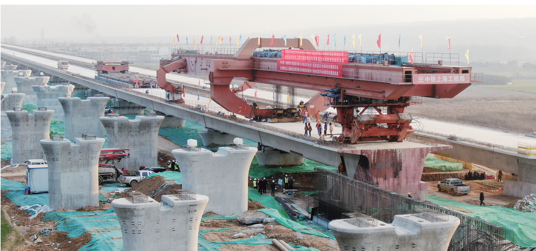
12月25日，中铁上海工程局施工人员操作架设西十高铁西安方向最后一孔箱梁（无人照照片）。当日，随着架桥机将一孔长24.6米、重563.16吨的箱梁平稳落在沪河特大桥桥台上，西十高铁西安方向箱梁架设圆满完成。西十高铁西安方向箱梁于2024年3月开始架设，总长19公里，总计架设箱梁416孔。西十高铁开通后，西安至十堰将实现1小时到达，西安至武汉将实现2.5小时左右到达，对加强关中城市群与长江中游城市群联系，带动沿线社会经济发展等具有重要意义。新华社记者 李一博摄
