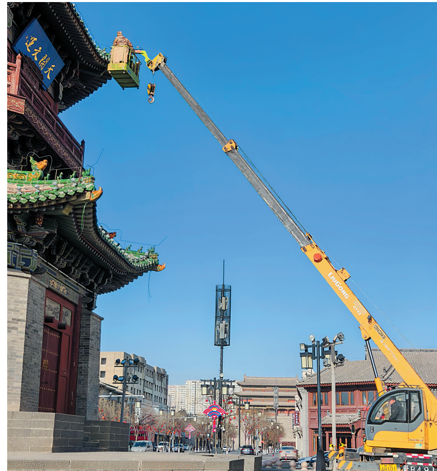
为打造良好旅游环境，连日来，我市城建部门为古城内标志性建筑悬挂灯笼、铺设亮化设施，营造节日氛围。图为昨日，城建部门工作人员在魁星楼安装亮化灯带。 本报记者 张占兵摄
