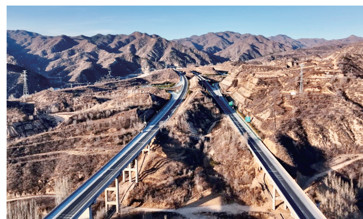
12月30日，京蔚高速全线建成通车。图片由受访单位提供
