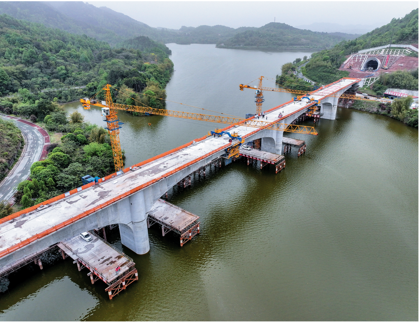
成渝中线高铁 玄天湖双线大桥合龙
