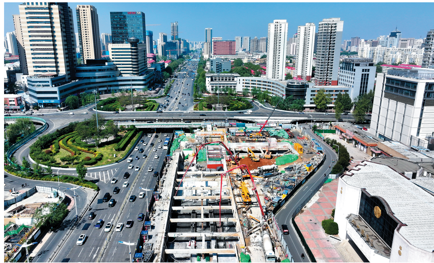
济南地铁四号线（一期）完成全线主体结构施工
