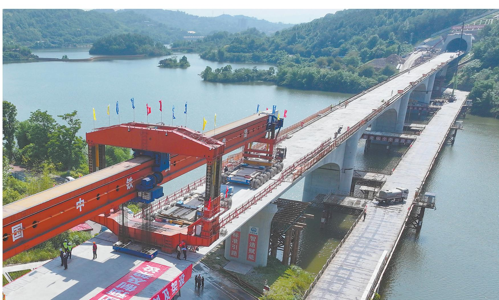
5月7日，在成渝中线高铁玄天湖双线大桥建设现场，架梁机在架设最后一孔箱梁（无人机照片）。
