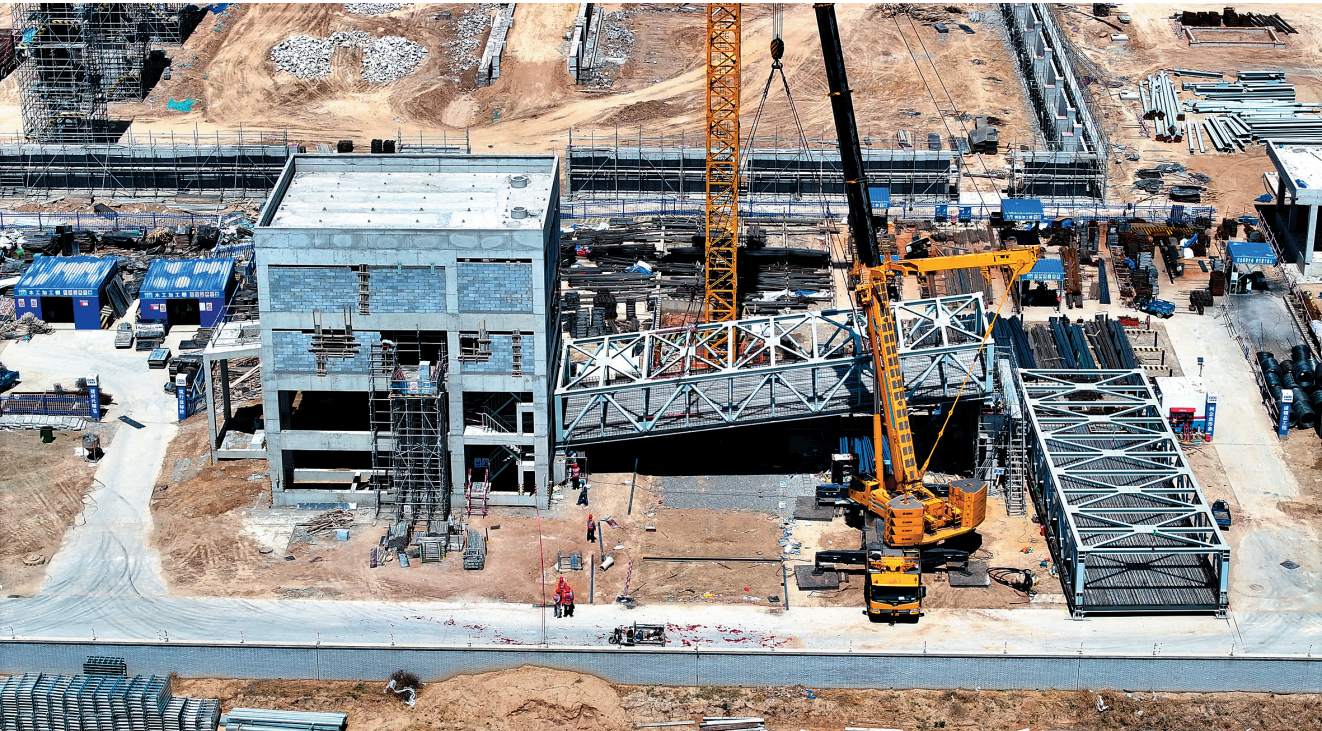
图为国电电力湖东电厂首跨输煤栈桥正在吊装。
