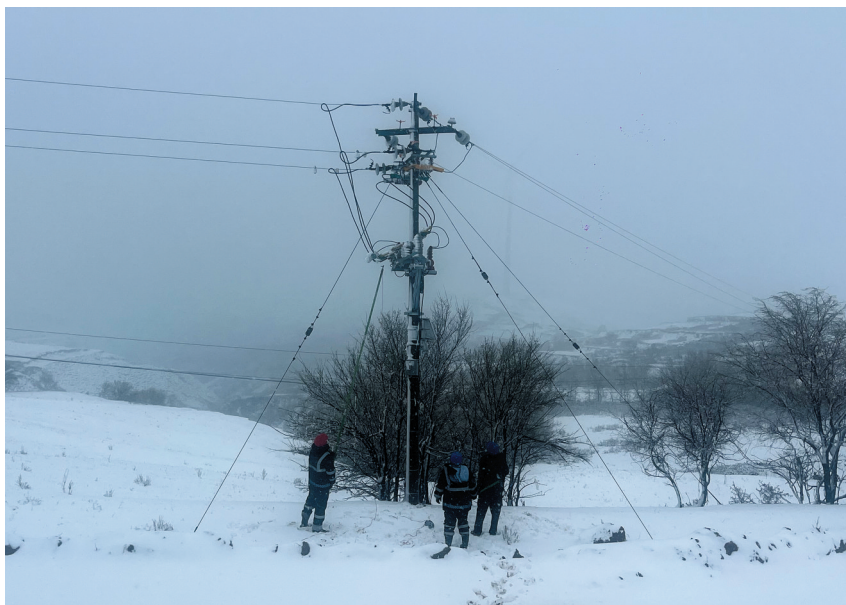
5月9日，天镇县出现雨雪大风天气，给当地电力设施带来严峻考验。当日11时21分，10千伏南高崖线13号智能断路器掉闸，导致部分区域供电中断。国网天镇县供电公司迅速行动，组织抢修人员在雨雪交加中赶赴现场，及时排除故障，恢复全线送电。
