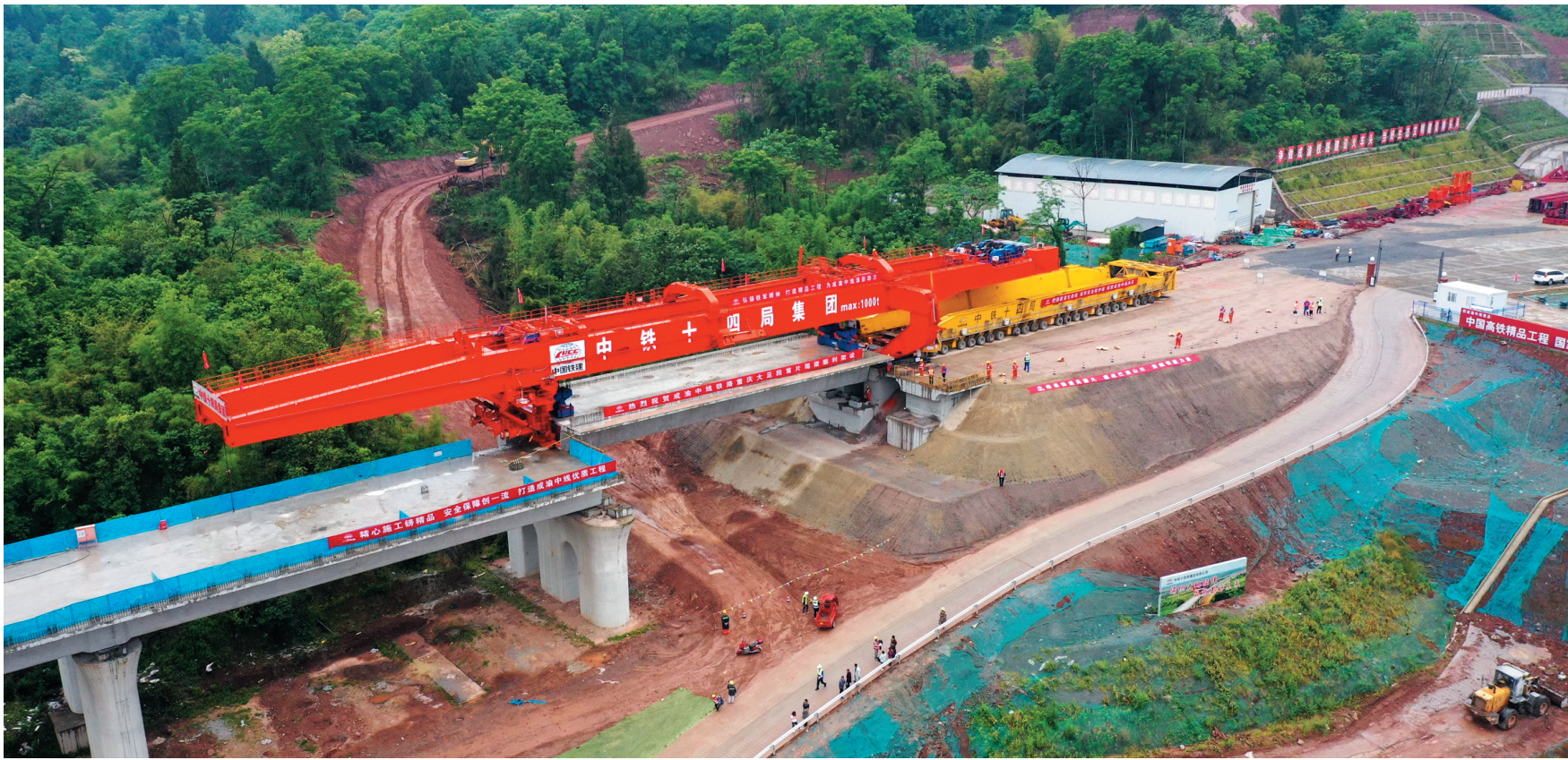
5月16日，成渝中线铁路重庆段大足石刻站四线道岔特大桥首片双线箱梁进入安装阶段（无人机照片）。
