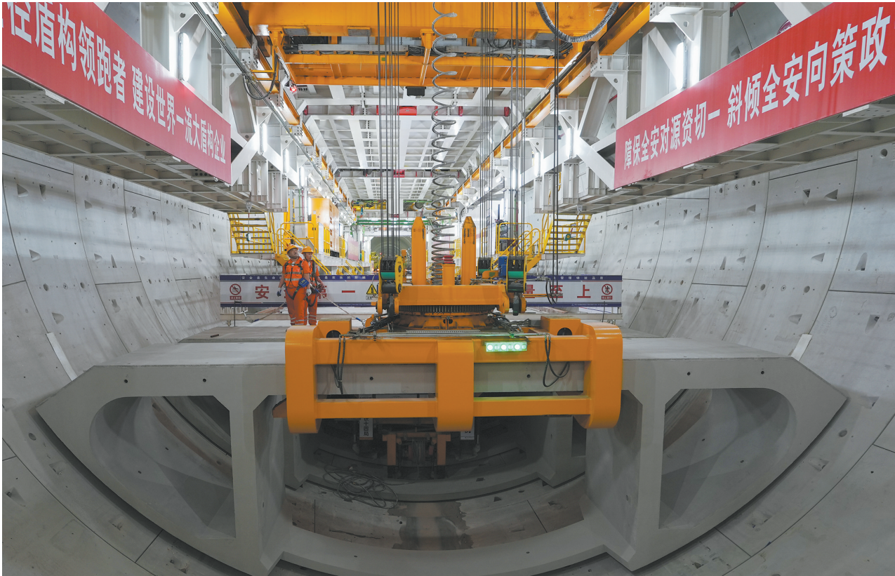
5月29日,中铁十四局技术人员在甬舟铁路金塘海底隧道“甬舟号”盾构机内操作箱吊吊机拼装弧形构件。当日,在中铁十四局承建的甬舟铁路金塘海底隧道宁波侧地下64米深处,“甬舟号”盾构机成功穿越海堤,由陆域段进入海域段掘进施工,标志着隧道建设全面进入“穿海之旅”。甬舟铁路金塘海底隧道西起浙江宁波市北仑区,东至舟山市金塘镇,全长16.18公里,是世界最长海底高铁隧道。
