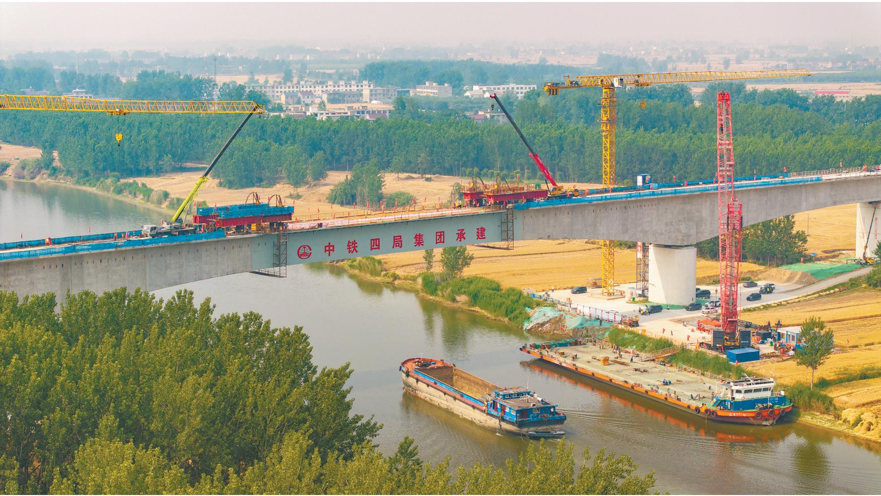
这是合龙后的中铁四局阜淮铁路跨涡河特大桥（5月29日摄，无人机照片）。5月29日，由中铁四局承建的阜淮铁路跨涡河特大桥最后一节重880吨的钢箱梁成功完成吊装，标志着阜淮铁路跨涡河特大桥合龙。阜淮铁路位于安徽省北部，途经阜阳、亳州、宿州、淮北，正线全长约142.5公里，设计时速350公里。
