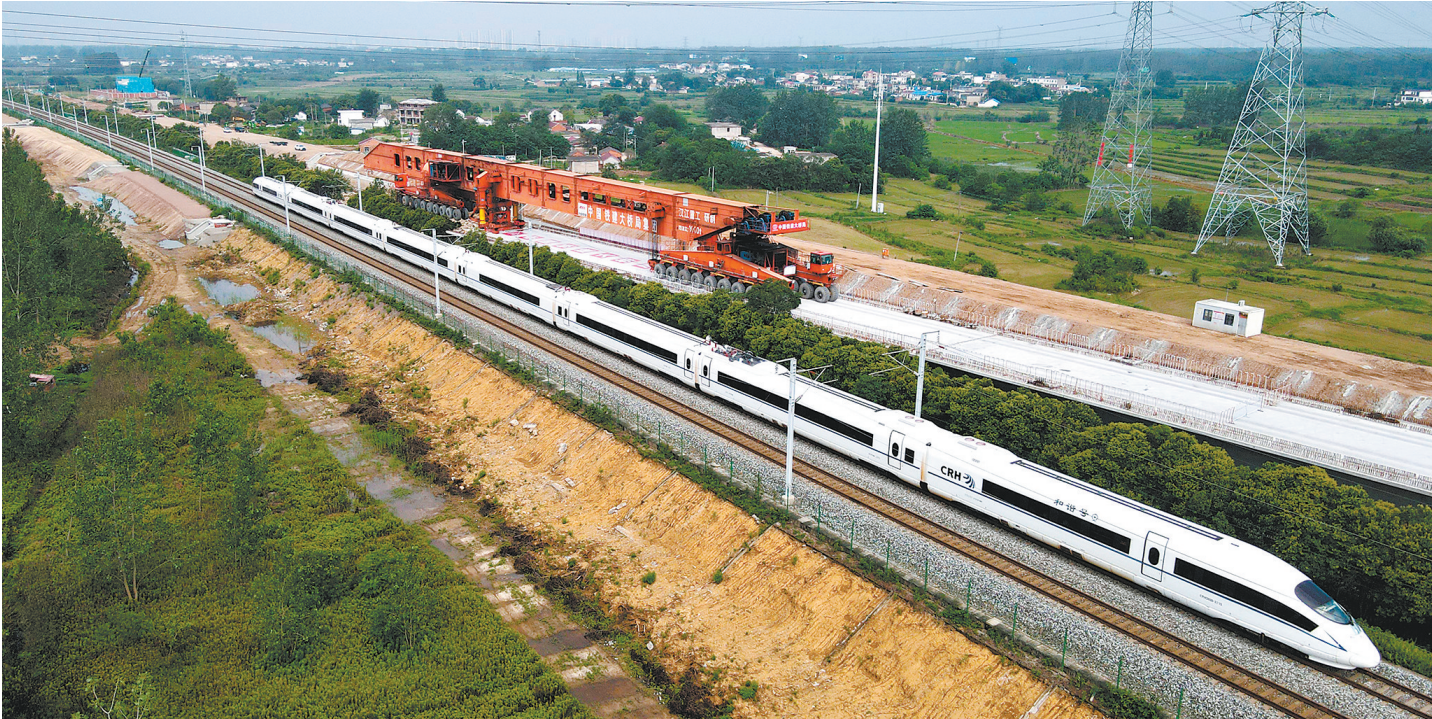
新建沪宁合高铁安徽段站前四标最后一根40米箱梁完成架设(6月25日报,无人机照片)。
