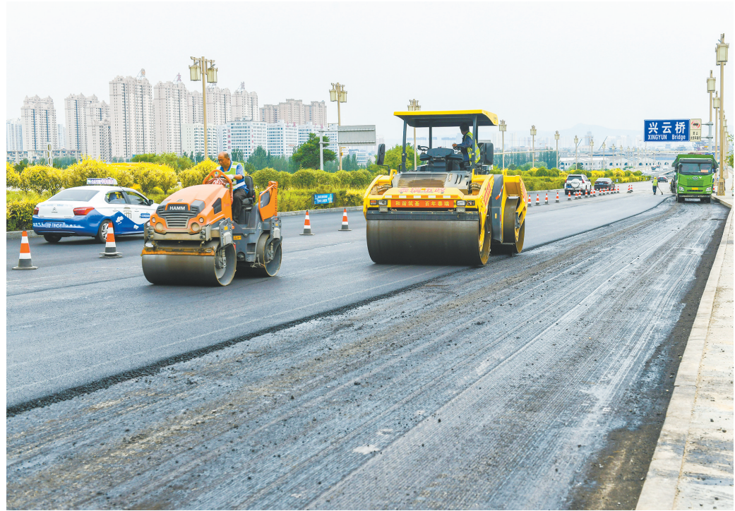
6 月 25 日晚，市城市管理局开启兴云桥由东向西 2000 平方米病害路面养护作业，次日 11 时，路面养护工作完成。养护作业现场施工人員严格把控控制深度与摊铺厚度，对局部病害严重区域实施加深刨刨深度、增加结构层厚度等差异化处置，精准消除道路隐患，为市民提供安全、畅通的出行环境。 本报记者 于宏摄
