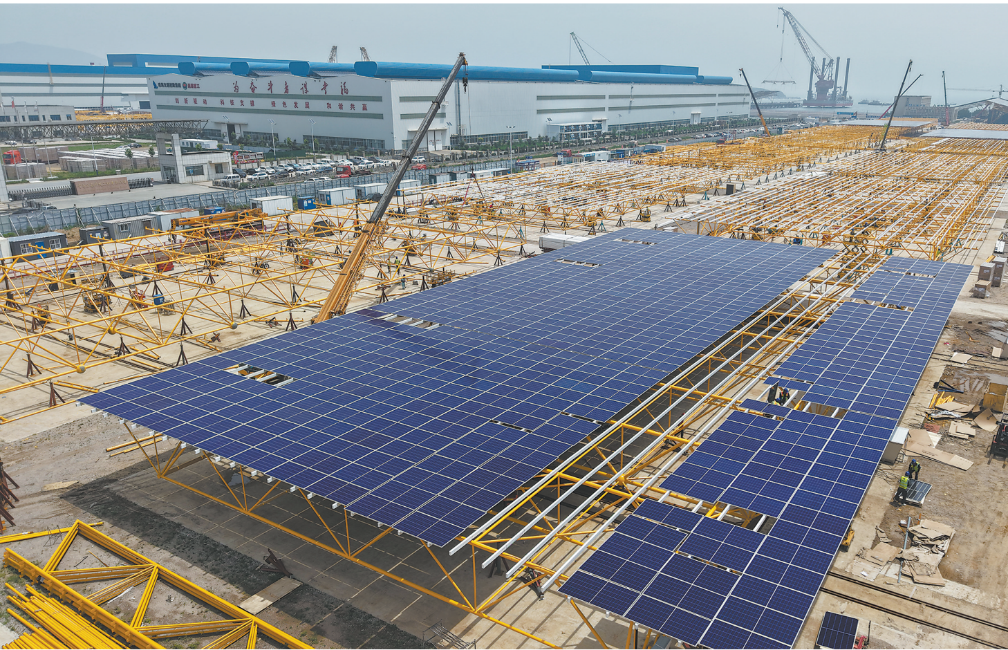
在青岛即墨海上光伏项目光伏平台组装场区，一樁正在组装中的光伏平台由1380块光伏板 and 支架组成(7月3日摄，无人机照片)。
