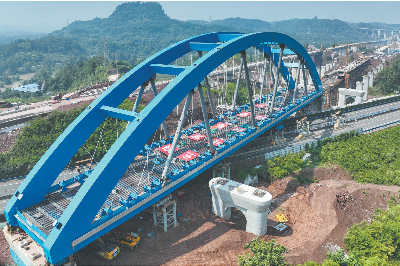
西渝高铁跨达高速公路大桥顶推施工完成
