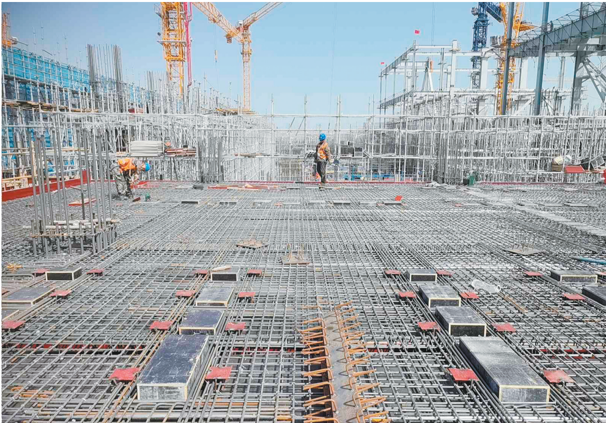
图为1号汽机房正在埋件安装。
