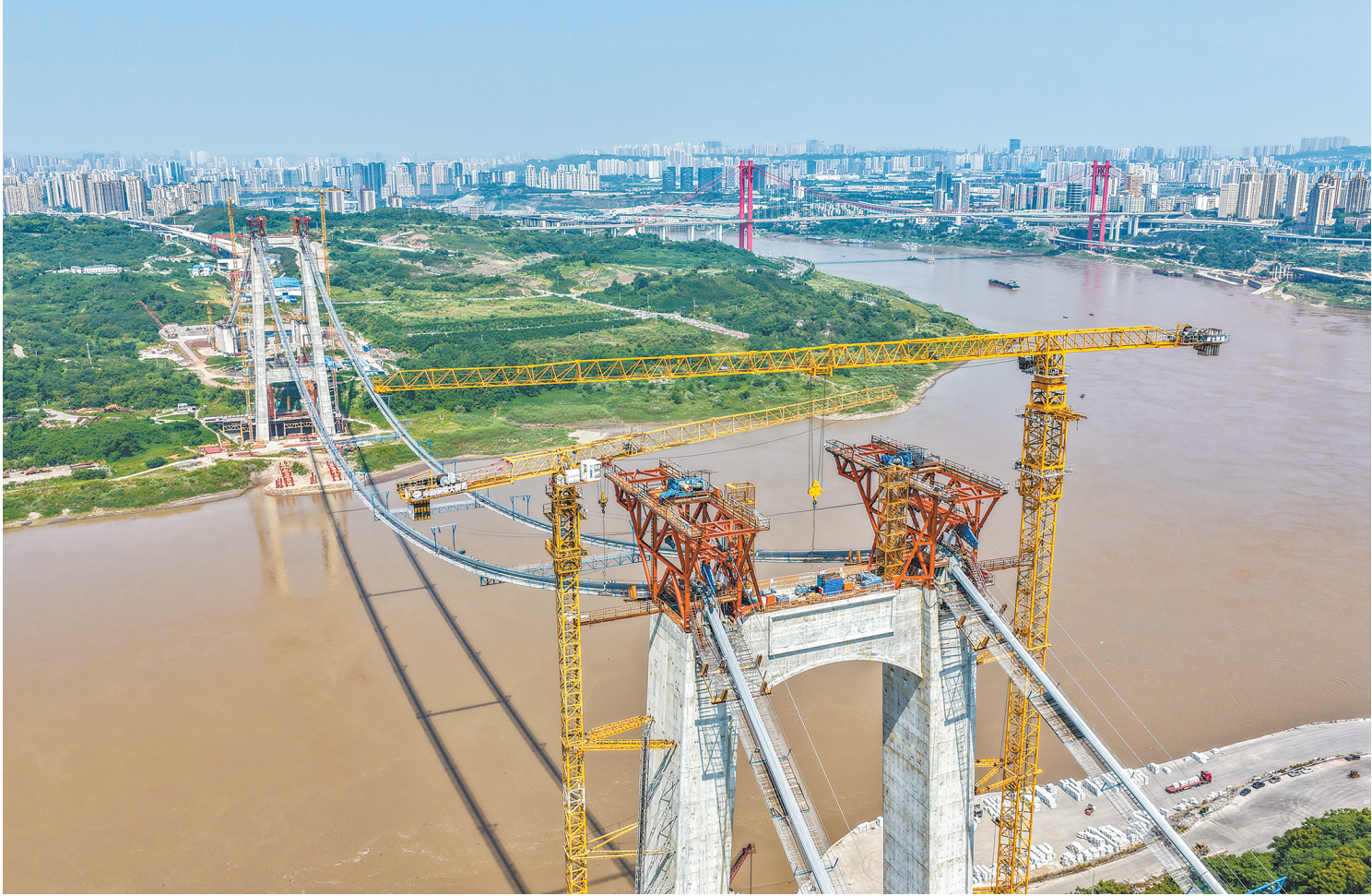
这是7月30日拍摄的重庆黄桶沱长江大桥主缆架设作业现场（无人机照片）。
