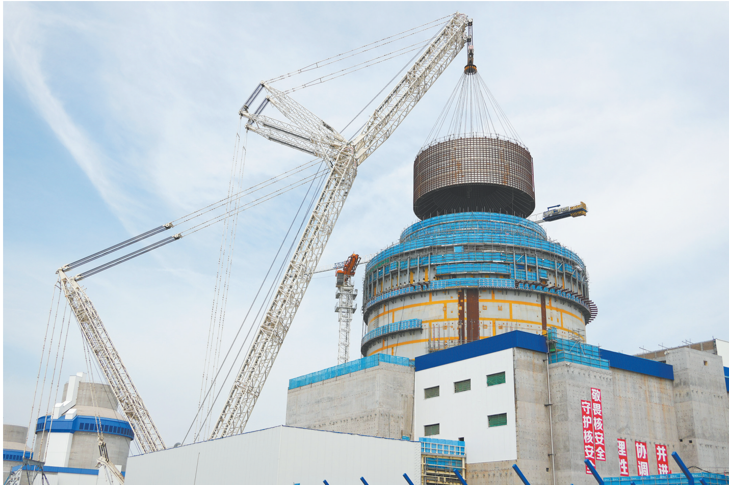
山东海阳核电3号机组核岛大型模块吊装完成
