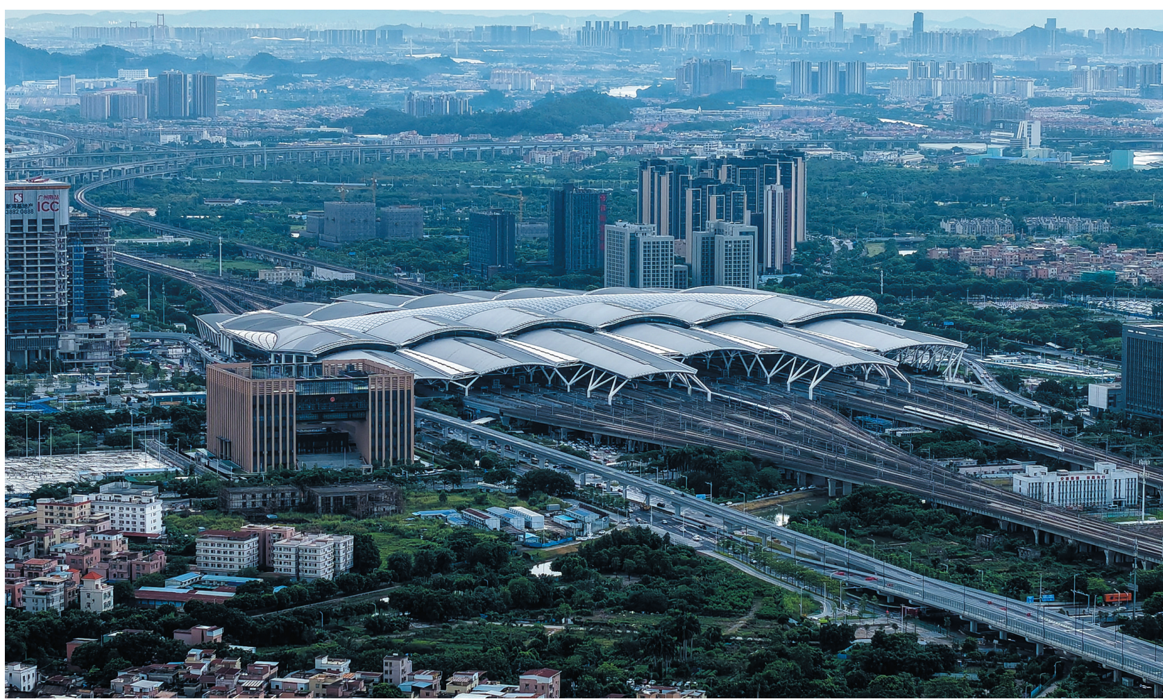
这是8月25日拍摄的广州南站（无人机照片）。广南联络线将从广州南站导出，一站直达位于中心城区的广州站。日前，由中铁十一局承建的广（广州站）南（广州南站）联络线建设取得新进展，“永庆号”盾构机稳步下穿陈村水道，跨动走线特大桥连续梁施工即将完成。广南联络线建成后，京广高铁、广深港高铁、贵广高铁、南广高铁等铁路线可直达位于中心城区的广州火车站，广州大都会交通枢纽功能将进一步增强。
